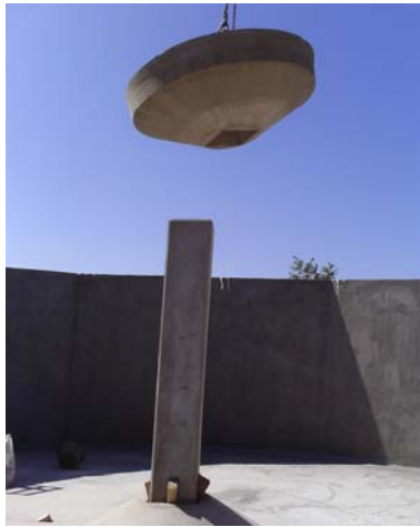
COLOCACIÓN DEL CAPITEL Y PILAR (A REALIZAR POR PREHORMISA)
